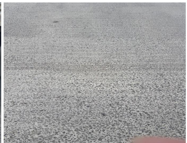
Mặt đường tạo nhám tốt
