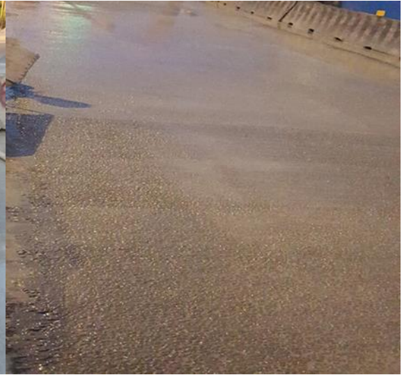
Bề mặt đã hoàn thiện
