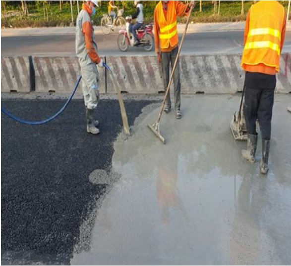
Trong quá trình thi công
